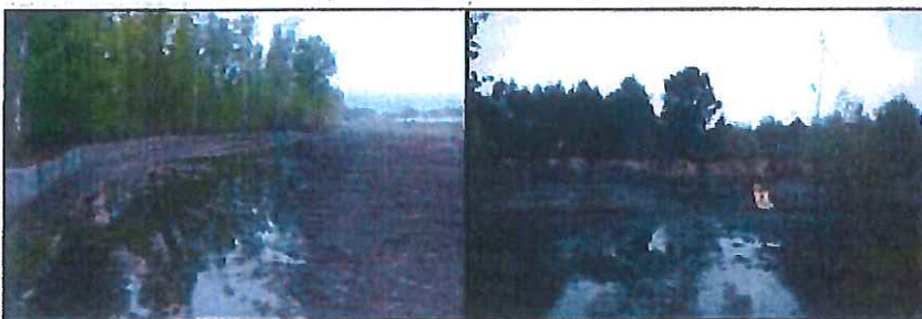
Ornières et fosses favorables aux amphibiens créées par des engins de chantier (Photographies : Naturalia)
