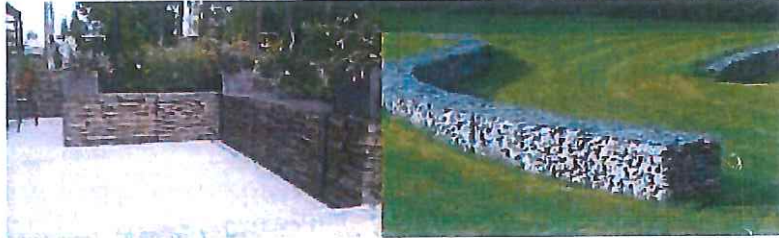
Exemple de gabions - Source : jardinsanimés.com
